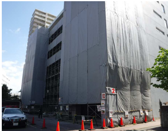
外部架構施工状況
