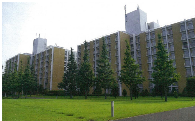
完成又は施工状況写真
