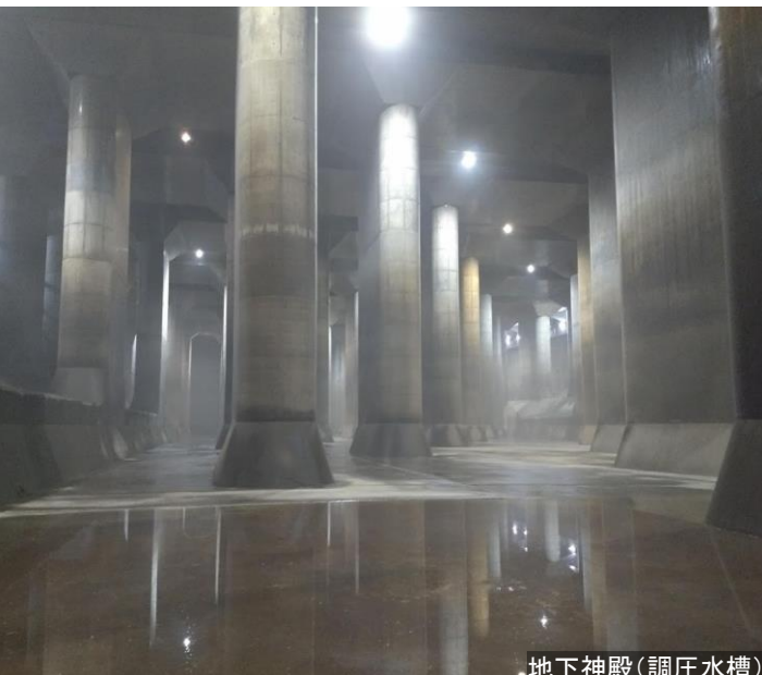
地下神殿(調圧水槽)
