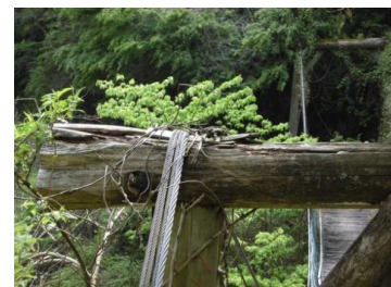
塔柱水平材 腐食
