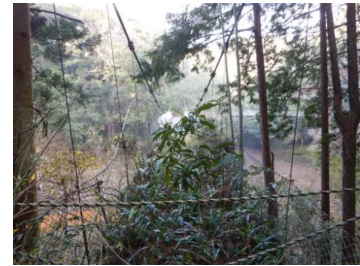
橋面（土砂堆積状況）
