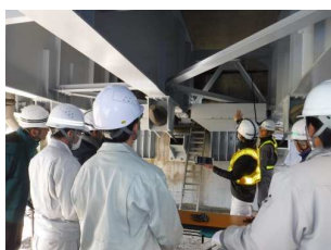
橋梁点検講習会
