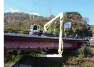
橋梁点検車による点検状況
