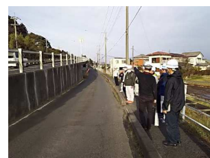
橋梁修繕工事現場見学会（断面補修）
