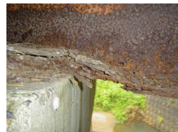
主桁座掘状況
