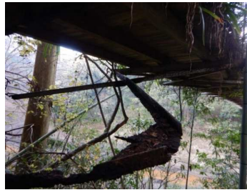
吊材定着材の機能不全
