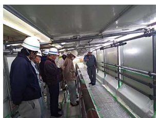
橋梁修繕工事現場見学会（塗装塗替）
