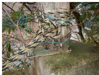
塔柱基部 腐食・傾き
