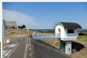
訓練の舞台と なった新町第3 樋管
