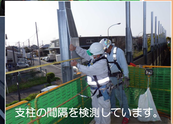
支柱接合部の確認をしています。
