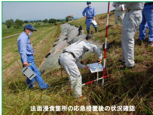
法面浸食箇所の応急措置後の状況確認
