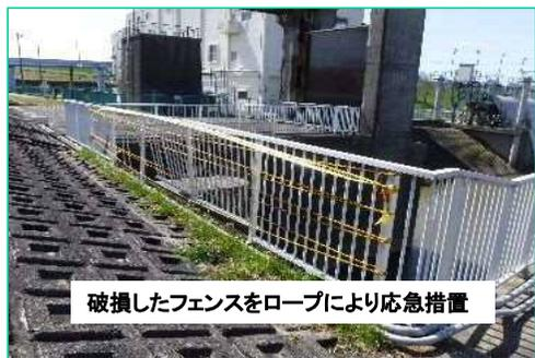
破損したフェンスをロープにより応急措置
