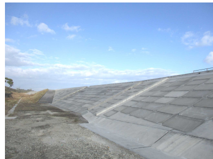
写真1:足洗海岸 堤防整備状況
