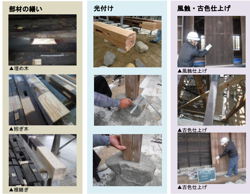
伝統的な工法を用いた整備
