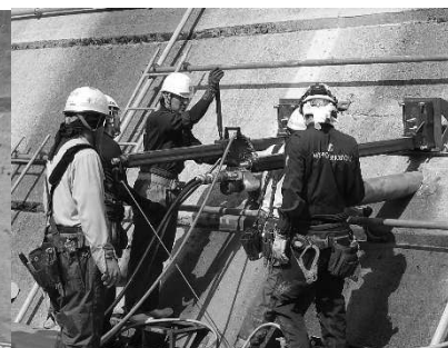
写真4 コア抜き削孔状況
