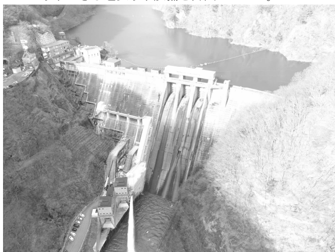
写真1 五十里ダム全景（試験放流中）
