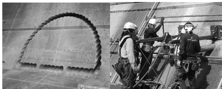
写真3 コア抜き連孔削孔完了（上半部）
