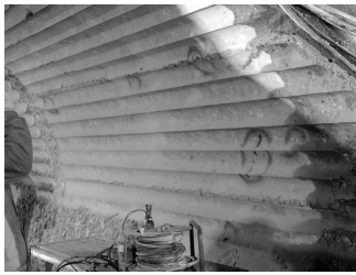
写真6 コンクリートブロック引出後
