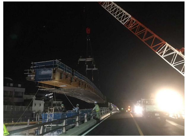
図-12 架設状況写真①
