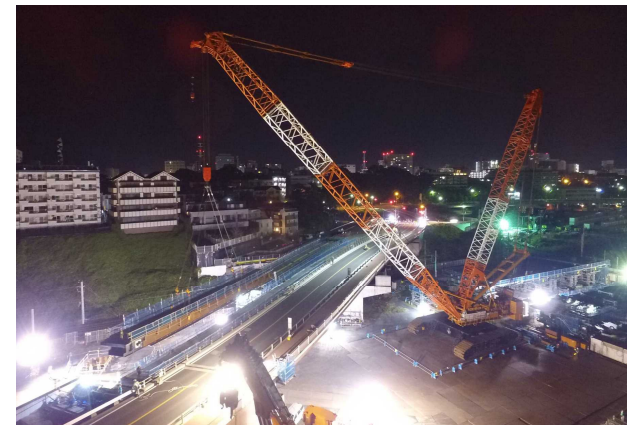
図-13 架設状況写真②
