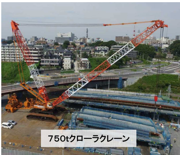
図-7 今回使用したクレーンの写真
