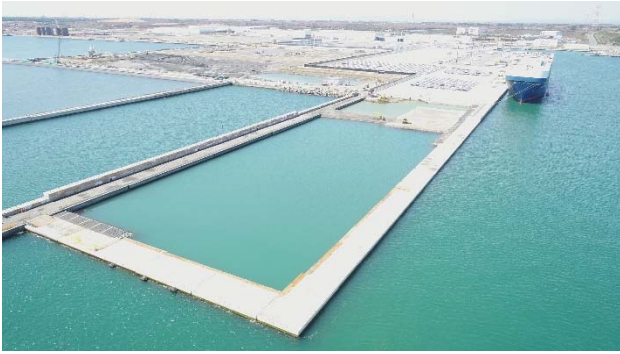
図-6 中仕切り堤施工完了について
