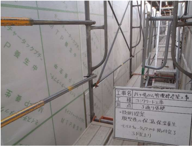
写真-5 「コンクリート保温養生気泡緩衝シートによる養生工法」(NETIS登録番号:HK-150002-A)
