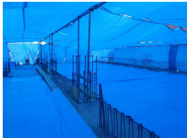
写真-4 断熱養生工法(NETIS登録番号:KT-070067-V) (スラブ面に敷設しているもの)
