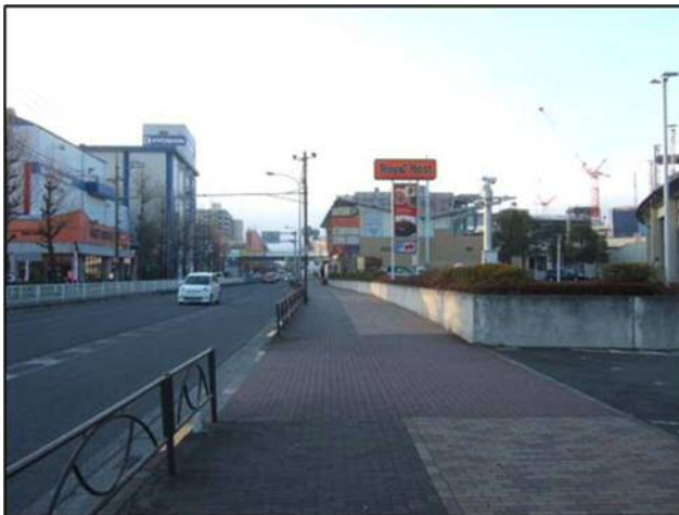
図-3 整備前の歩道の状況（スタジアム前区間）
