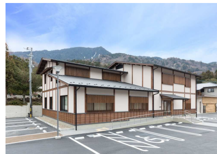
図-1 木曾森林管理署南木曾支署 外観
