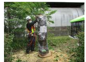
写真-5 切断状況
