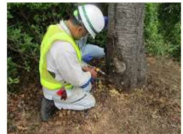
写真-3 薬剤注入状況
