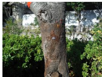
写真-8 フラス排出状況
