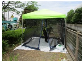
写真-6 テント設置
