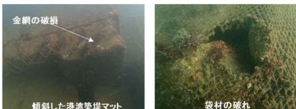
写真-3 健全度調査による施設の健全度状況
