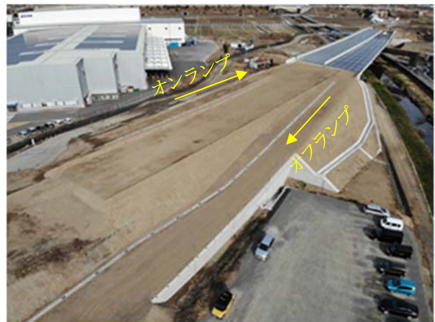
写真-1 現場完成写真
