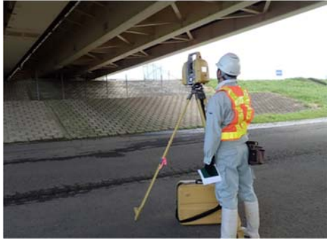
図-5 地上レーザ測量
