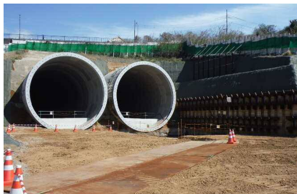
写真-3 施工が完了した館第一トンネル
