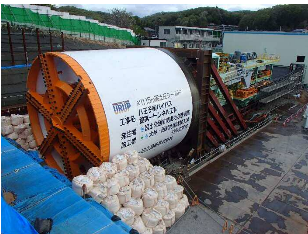
写真-1 URUP工法によるシールド機地上発進
