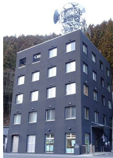
二瀬ダム管理所庁舎
