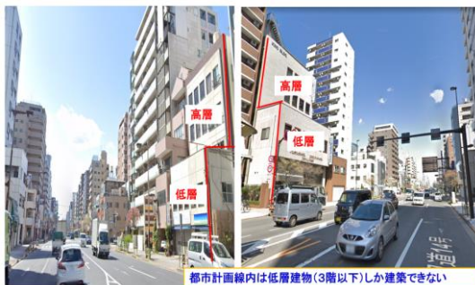
写真-1 両国拡幅（東京国道施行）現地写真
