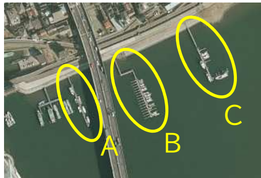
図2 暫定係留施設（ABC 栈橋）
