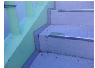
写真-10 階段端部シール
