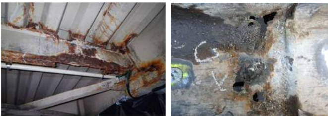
写真-5 デッキプレートは損傷が少なく 写真-6 凹部内に透し腐食横桁は欠損
