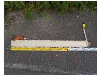
写真-2 落下した当て板部材
