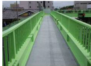
写真-9 通路補修後全景
