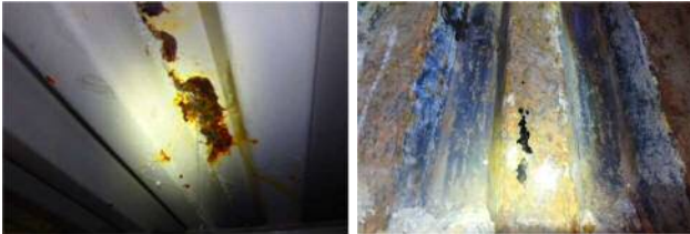
写真-3 凸部孔食からの漏水 写真-4 凸部継目の孔食・凹部健全
