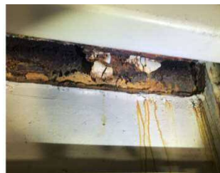
写真-1 デッキプレート端部
