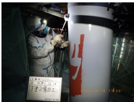
写真-14 塗替塗装施工状況
