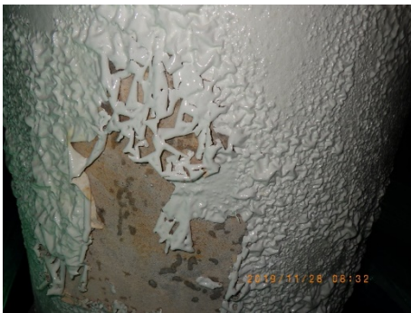
写真-13 剥離剤反応状況
