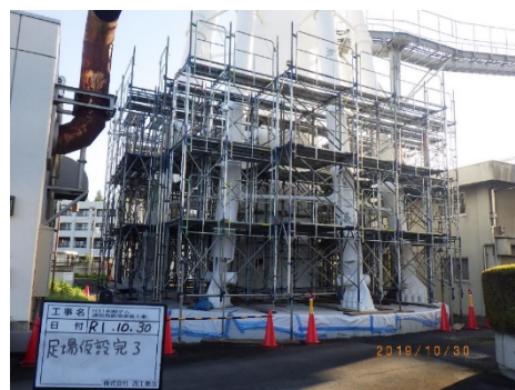
写真-8 足場設置状況
