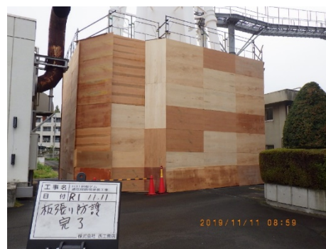
写真-9 足場板張り防護状況
