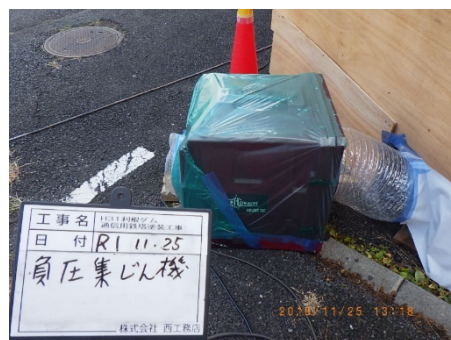
写真-10 負圧集じん機設置状況
