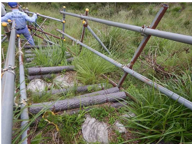
写真-7：階段の踏み代がバラバラの状態
