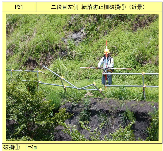
写真-4：施設点検における安全施設の点検記録
