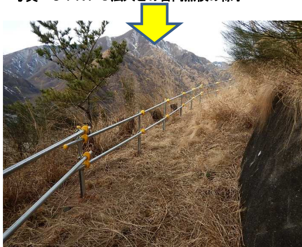
写真-6：ロープ柵から単管柵への付け替え後
