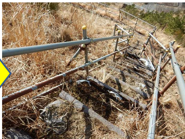
写真-8：歩きやすい踏み代になるよう補修
