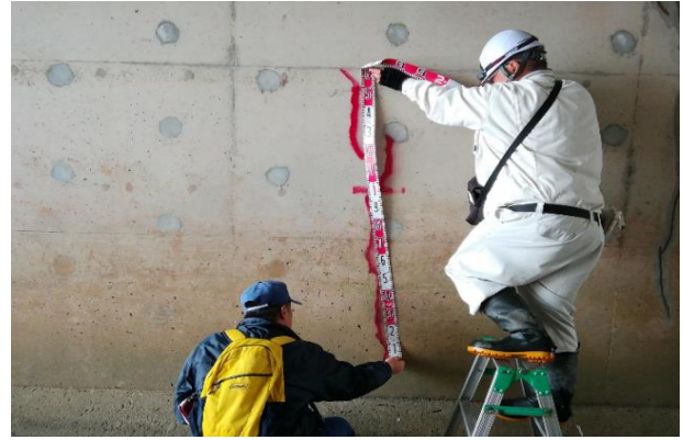
写真-1 構造物点検（樋管の内壁）
