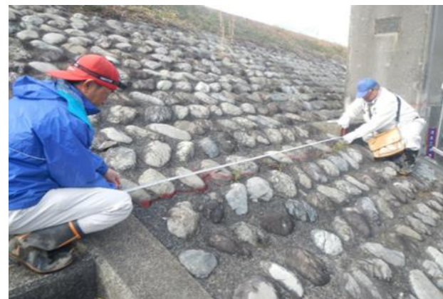
写真-2 構造物点検（樋管取り付け護岸）
