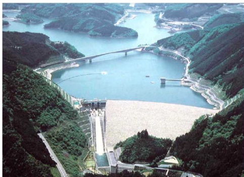
図-2 阿木川ダム（堤高101.5m、岐阜県恵那市）
