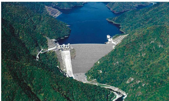
図-7 徳山ダム（堤高161.0m,岐阜県揖斐川町）
