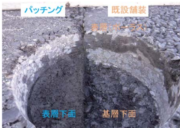
写真-3 水の浸透状況
