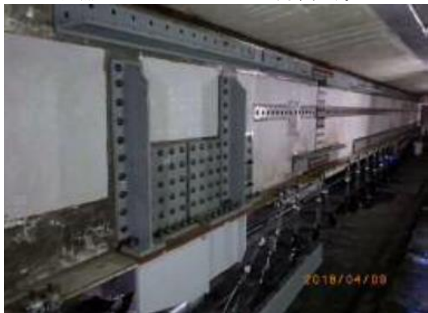
写真-4 外ケーブルでの主桁補強
