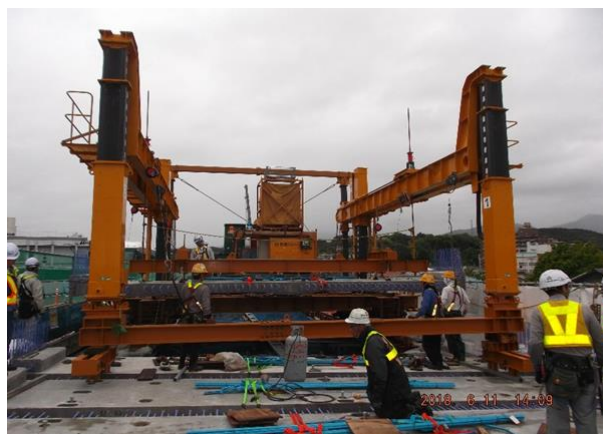
写真-6 プレキャストPC床版架設状況
