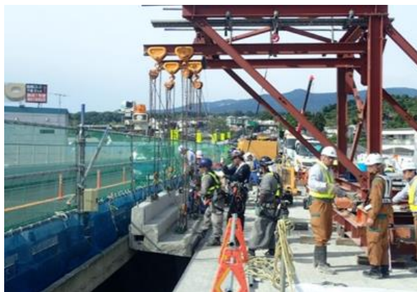
写真-3 張出床版の撤去状況（高欄吊上げ）
