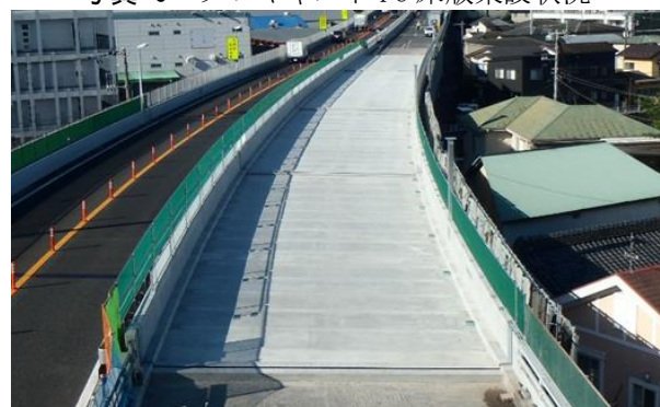
写真-7 主版取替完了
