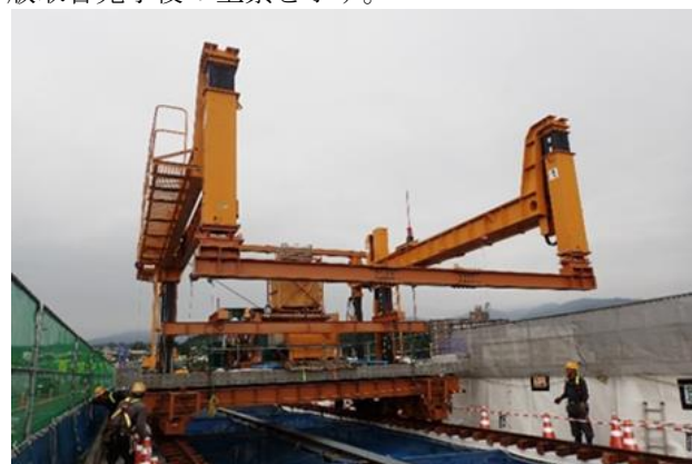
写真-5 床版架設機走行状況
