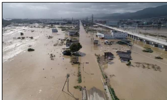
写真-1 国道18号の冠水状況（ドローン撮影）
