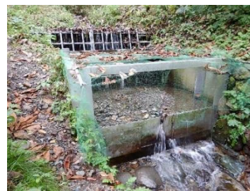
写真-1 出水により土砂が溜まった複合堰
