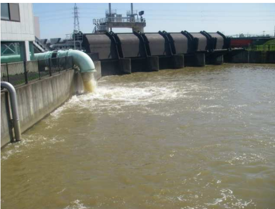
写真-2 残水排水の様子
