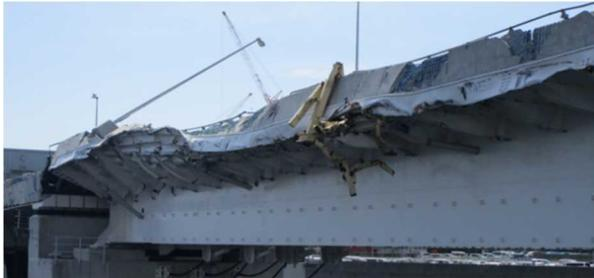
写真-2 はま道路の被災状況 (鋼床板箱桁橋)
