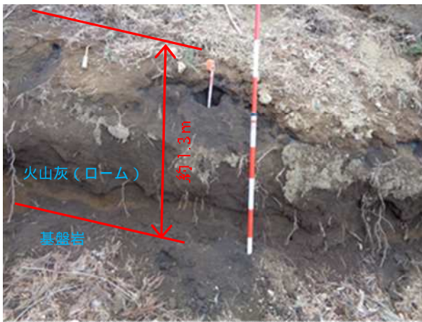
図-4 被災斜面の露頭状況写真
