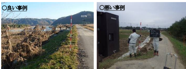
写真-2 痕跡調査の状況
