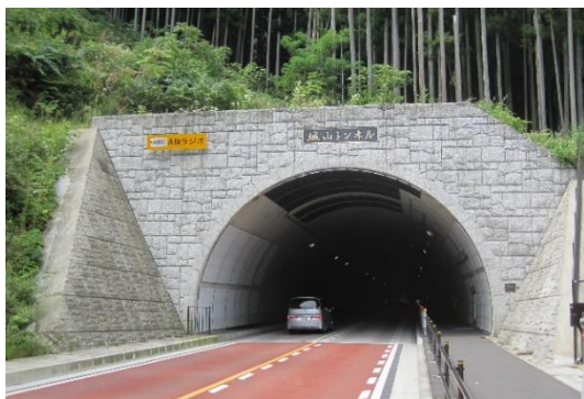
写真-2 城山工区（完成）
