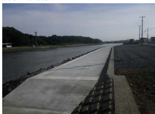
護岸の修繕後
