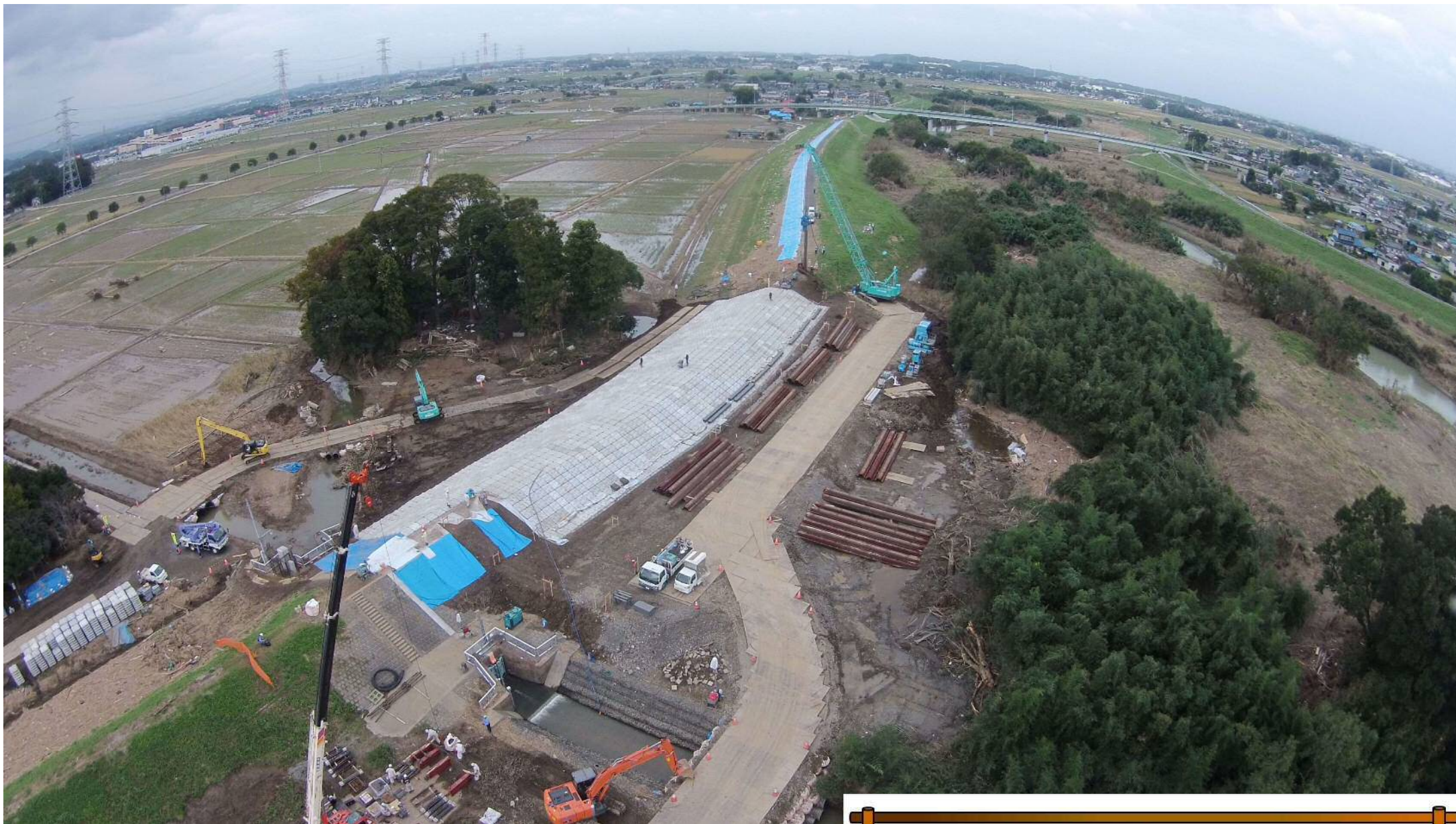
作品タイトル：都幾川堤防の災害復旧 撮影者コメント：1ヶ月間24時間施工を行い完成しました 撮影日・撮影場所：2019/10/24 都幾川右岸0.4km(東松山市早俣地先) 撮影者会社名：伊田テク/ス(株) 撮影者：柿沼 美行
