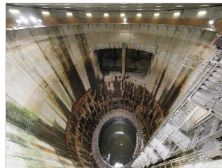
首都圏外郭放水路(第一立坑)
