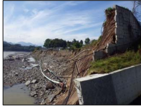
市道白鳥神社線海野宿橋 (長野県東御市)
