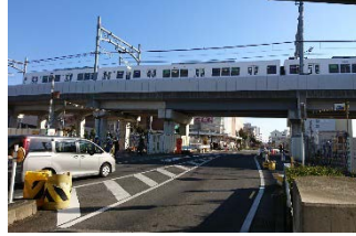
新鎌ヶ谷駅付近 連続立体交差事業 (千葉県)
