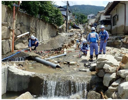
道路被災状況の調査
