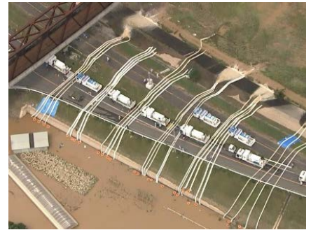
排水ポンプ車による緊急排水
