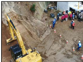
関係機関（建設業界等）との連携訓練
