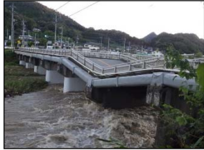
国道20号法雲寺 (山梨県大月市)
