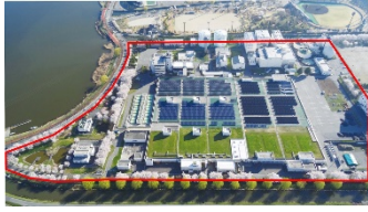
クリーンレイク諏訪 (諏訪湖流域下水道豊田終末処理場) (長野県諏訪市)
