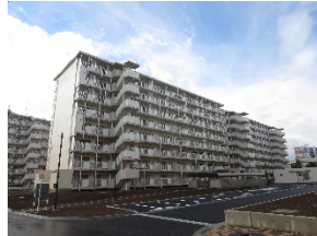
公営住宅整備事業 (東京都)
