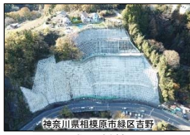
法面対策 神奈川県相模原市緑区吉野
