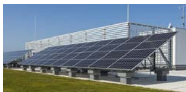
屋上緑化・太陽光パネル
