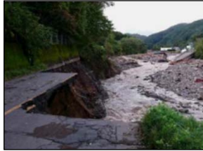
国道144号鳴岩橋 (群馬県嬭恋村)
