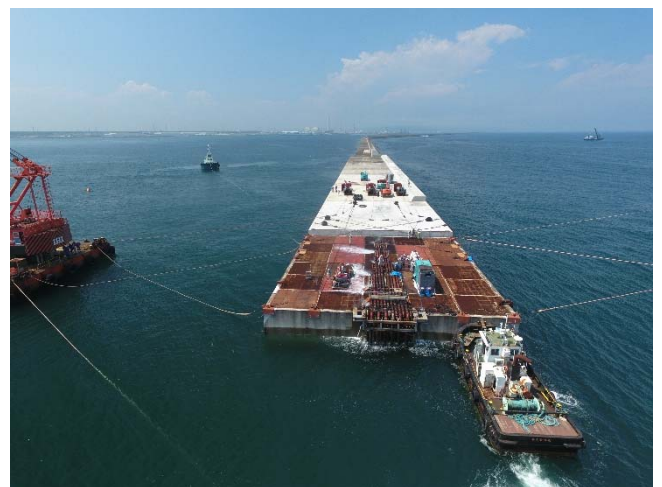
茨城港常陸那珂港区東防波堤工事状況 (5か年加速化計画対象工事)
