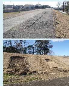
堤防の亀裂、陥没・法崩れ
