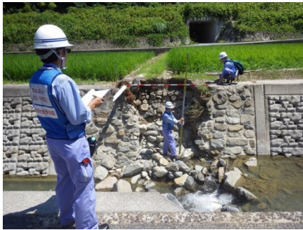
河川被災状況の調査
