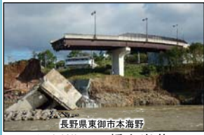
長野県東御市本海野 河川沿いの橋台崩落
