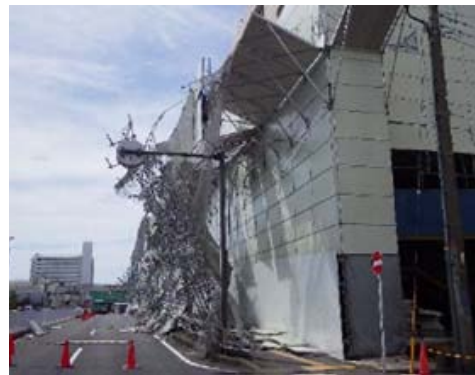
建物足場の倒壊(横浜市)
