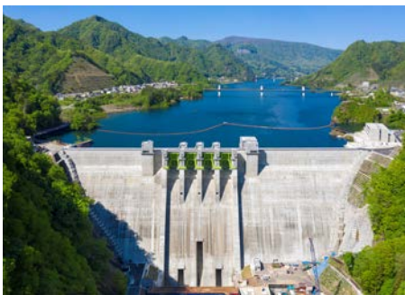
ハツ場ダム(ダムを活用した地域振興)
