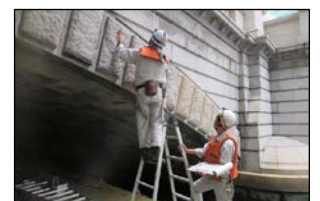
近接目視による橋梁点検
