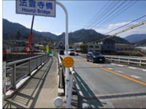
国道20号法雲寺仮橋歩道橋完成 (山梨県大月市)
