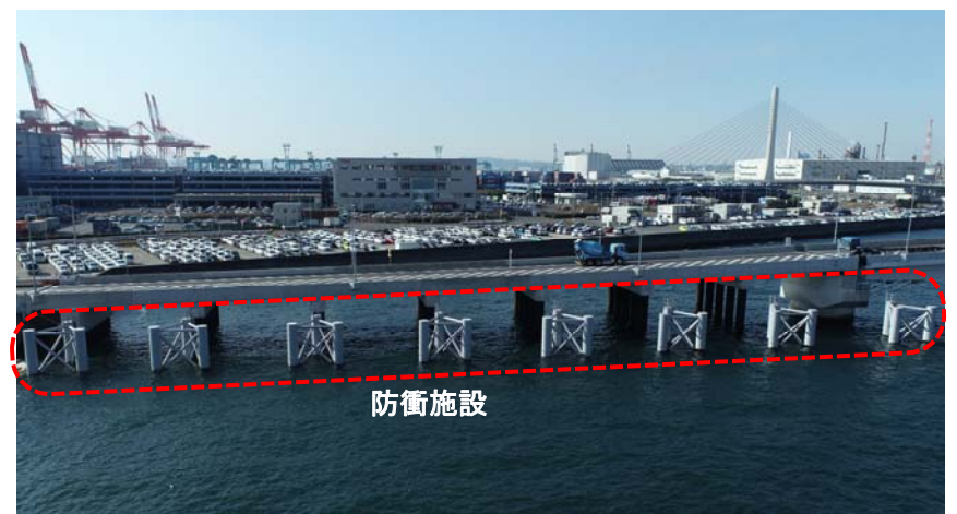
南本牧はま道路 防衝施設(令和2年12月完成)
