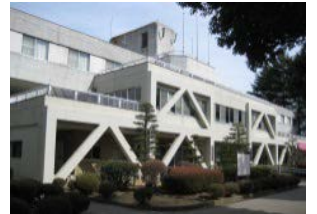
総合運動公園事務所 (栃木県)
