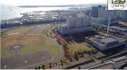
首都直下地震等の大規模災害時に政府の現地対策本部が設置される
