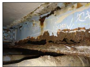
漏水による橋桁の腐食
