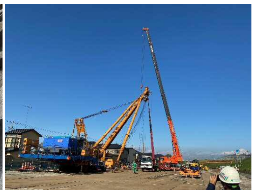
【地盤改良始めます。】 撮影者会社名・撮影者:中原建設(株) 玉木大介
