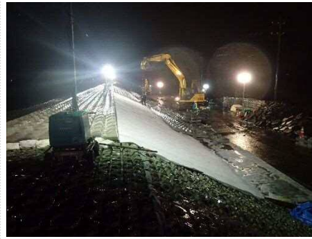
【正義の味方登場！雨にも負けず復旧作業】
