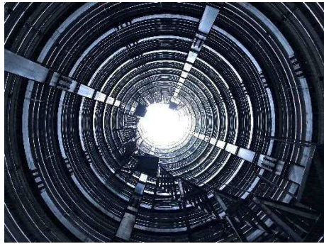
【地下21mから見上げる空】
