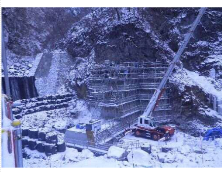
【床固工左岸側完成、あと足場解体。】
