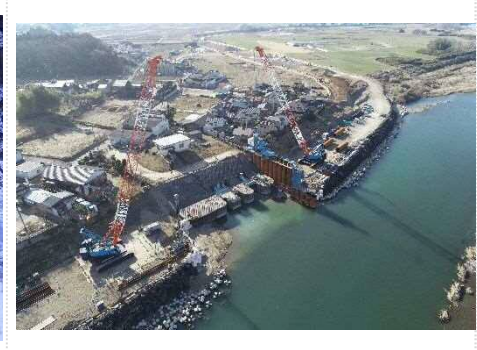
【世界最大のマシンで堤防護岸を鋭意施工中】
