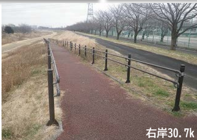
緩傾斜坂路(スロープ)(35箇所/84箇所)
