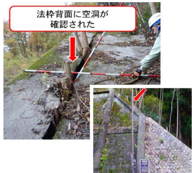
図-8 のり枠天端部分に確認された開口部の状況 (例)
