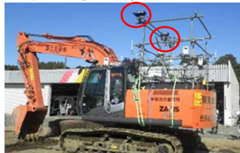
写真-2 仮説取付架台
