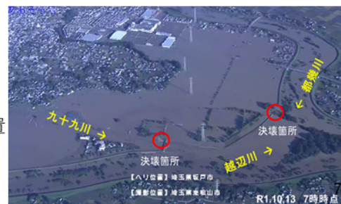
入間川流域における浸水被害状況
