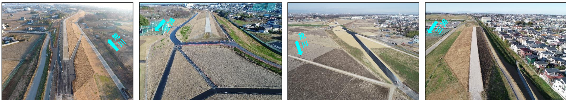
R1年度工事実施箇所
