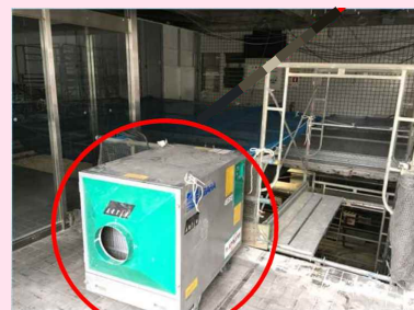
集塵機を設置し室内の換気を実施
