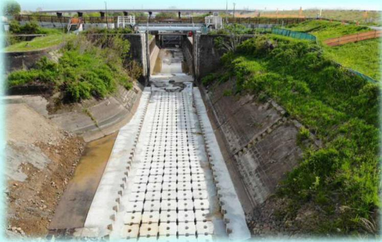
江戸川の水利用(水道用水・工業用水・農業用水)に必要な水量をより確実に流すため、関宿閘門の床版と護床工の高さを低くする工事を行いました。
