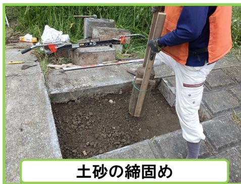
出水期を迎えるにあたり、坂川の護岸ブロック補修を実施しております。護岸ブロック裏側に空洞ができ、護岸の一部に沈下が確認されたため、補修を進めています。既存ブロックを撤去し、土砂を締固めた後、ブロックを復旧する作業を行っております。
