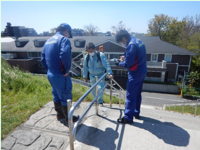
手すりの破損やガタつきを確認中
